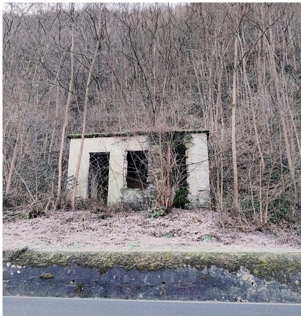
La centralina idroelettrica dismessa tra Sirta e Selvetta sarà rimpiazzata da un nuovo impianto
